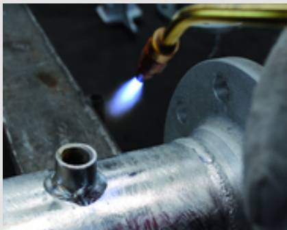
➔ Abb 1: Überflüssige Zinktropfen können mit weicher Flamme abgeschmolzen und danach mit Drahtbürste oder Blechspachtel beseitigt werden.
